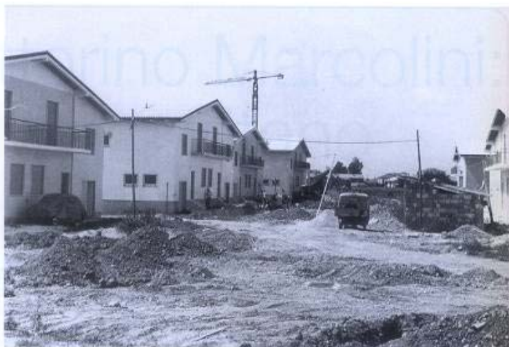
Cantiere degli anni Cinquanta alla Badia
