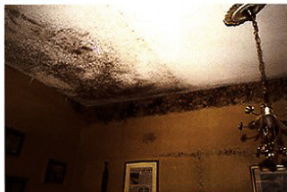
Foto 1 – Formazione di muffe diffusa, particolarmente marcate in corrispondenza di una trave in c.a.
